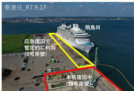
大田3号岸壁は応急復旧で利用を継続 隣接岸壁復旧後に大田3号岸壁を本格復旧
