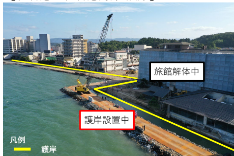
旅館復旧と護岸復旧を並行して進めるため 仮設道路を整備して海側から護岸を復旧
