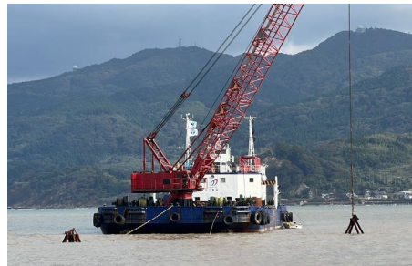
起重機船（弘武）による緊急浚渫状況
