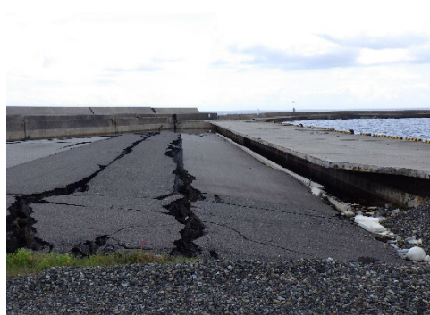
岸壁背後の陥没
